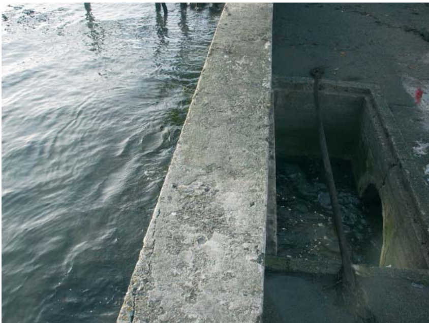
Eksempel på overløbsbygværk, hvor dækslet er slået af under stormen i november 2006.
