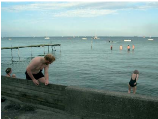
Betonnure og en lav stormport vanskeliggør adgang til kysten ud fra kvarterets veje som alle går helt ned til Øresund. 2007.
