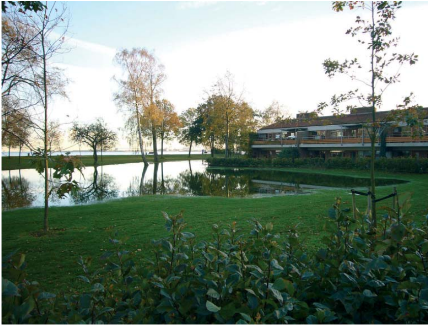
Strandlund efter stormen i november 2006. Store dele af grøningen ud mod Øresund står under vand.
