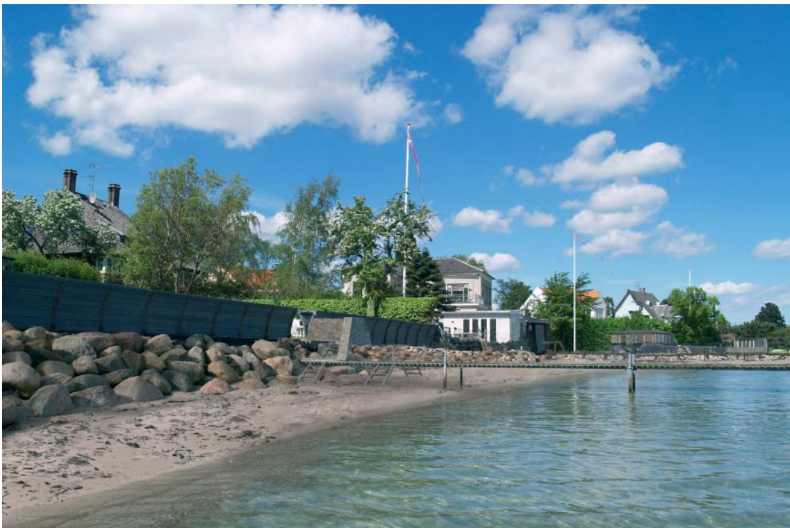
Et smalt strandprofil og en lavere bro. Kystbeskyttelsen kan samtidig forbedres med en stenkastning. Billedet viser hvordan en ca. 1 m høj bro gør det lettere for gående langs stranden at passere, og give let adgang mellem have og bro.
